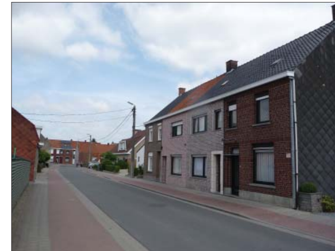
Zicht op de Stampkotstraat: • de Stampkotstraat is een wijkverzamelweg die bestaat uit een rijbaan met langs beide zijden verhoogde fietspaden en smalle voetpaden • er is een afwisseling van vrijstaande bebouwing en rijwoningen
