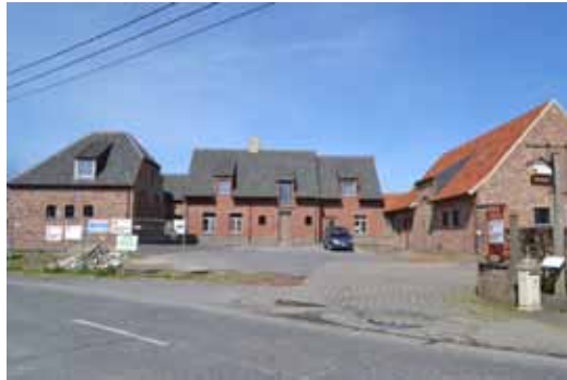
DEELS GERENOVEERDE HOEVE
