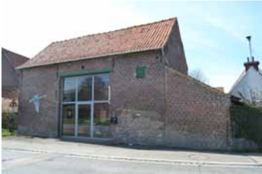
DEELS GERENOVEERDE HOEVE
