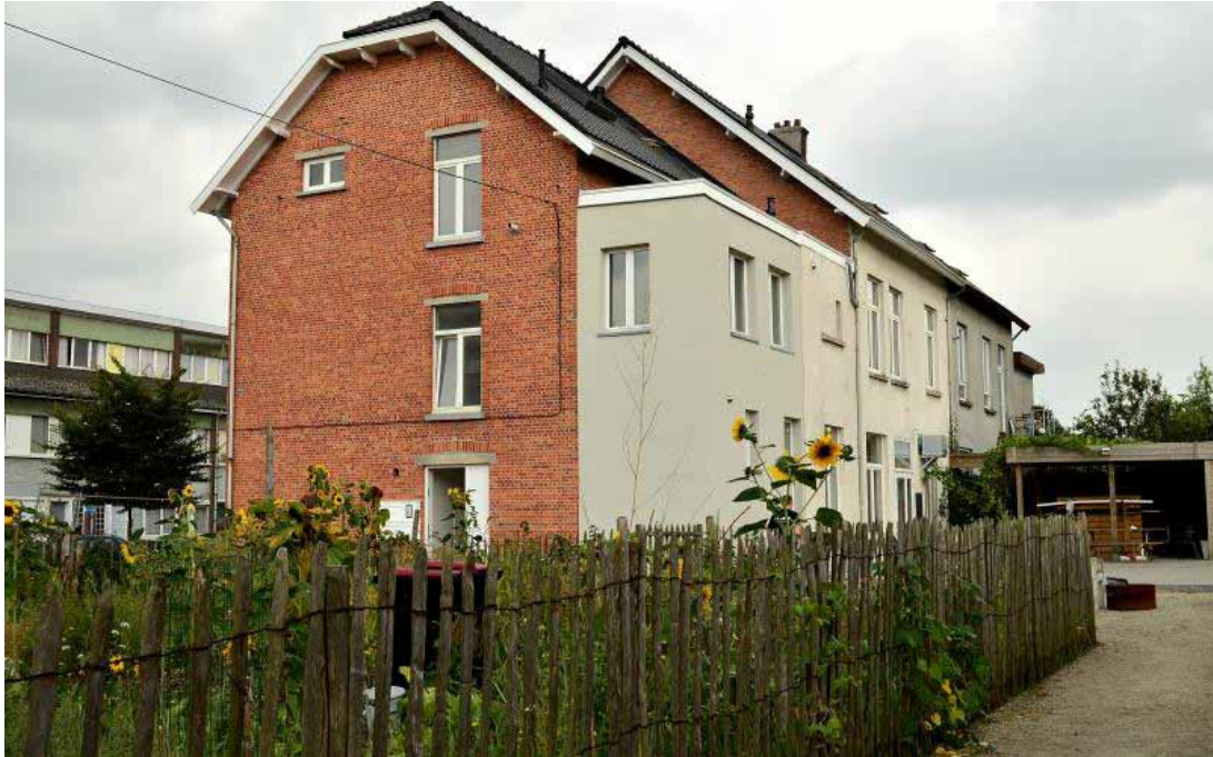
AANBOUW EN GEVELRENOVATIE LANGS DE ACHTERZIJDE VAN EEN VOORMALIG POSTGEBOUW DUIDELIJK ONDSCHIED TUSSEN WAT OUD EN NIEUW IS
