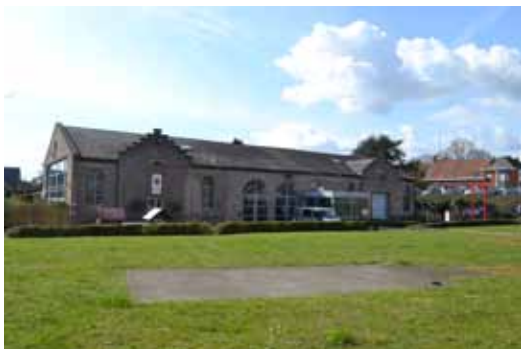
VOORMALIG POMPGEBOUW, HEDEN RESTAURANT
