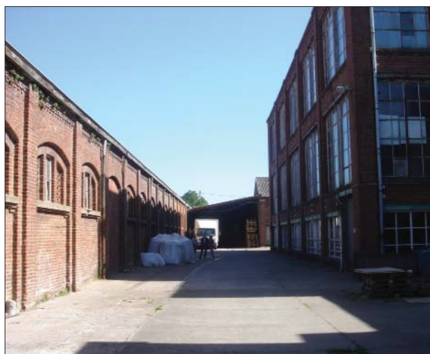
Zicht op de opslagplaats ten westen en het hoofdgebouw van de Grootte Fabrieke.
