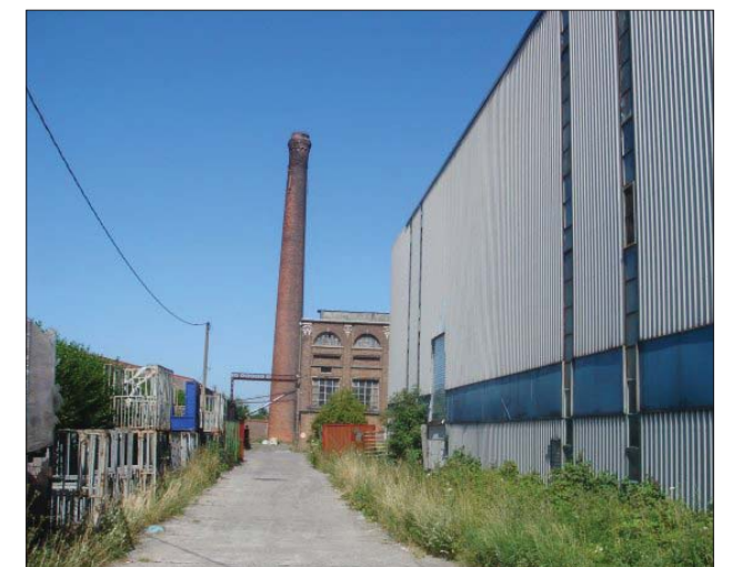
Zicht op de aanbouw in aluminium bardage.
