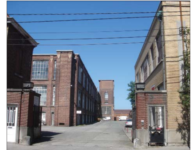
Zicht op het hoofdgebouw van 'de Grootte Fabriek' vanaf de toegangspoort langs de Doorniksesteenweg.
