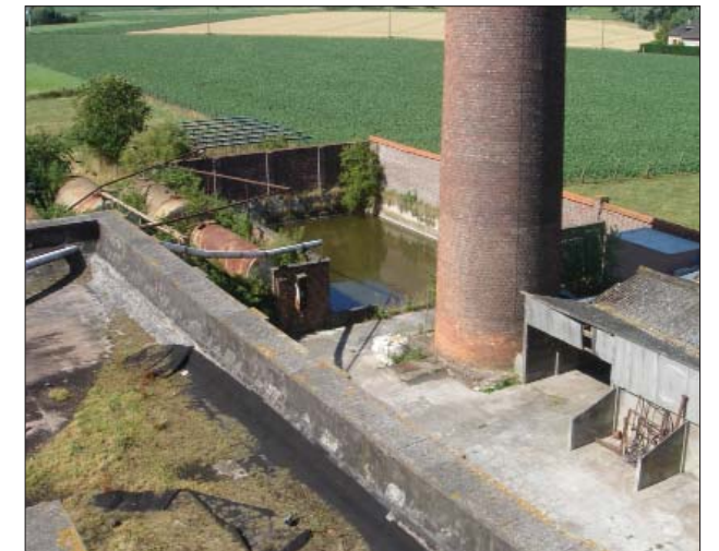
Zicht op de brandstofpomp, de koelvijver en de voet van de schoorsteen.
